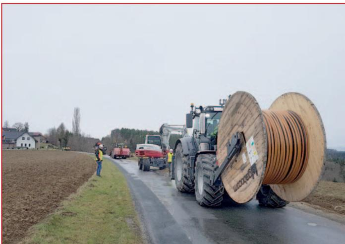
Ein 7-fach Minirohrverband wird mittels Layjet in das Straßenbankett verlegt.
